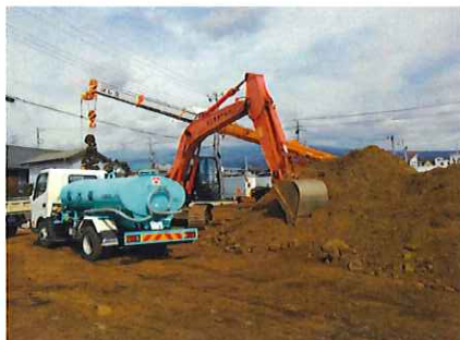
◎(出) 商業施設新築工事
